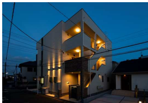
◆木造3階共同住宅 浦和別所 (2015. 5月竣工)
