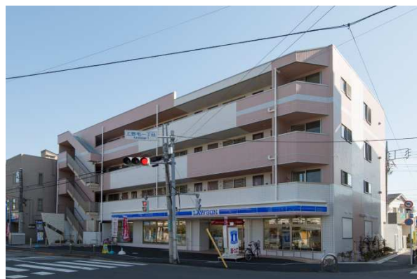
◆鉄骨造4階店舗・共同住宅 世田谷区 (2016. 2月竣工)
