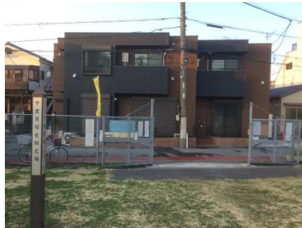
◆木造2階共同住宅 北区上中里 (2017年3月竣工)
